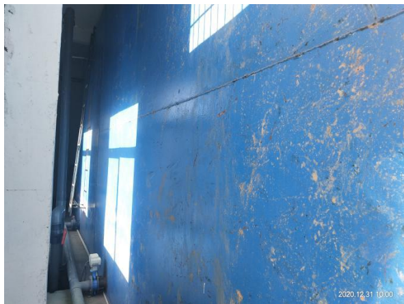
污水处理池体
